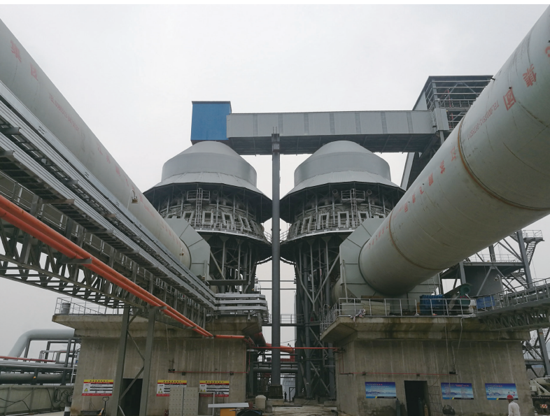
新疆托克逊县新家园高清材料科技发展有限公司 2×1000t/d 活性石灰生产线
