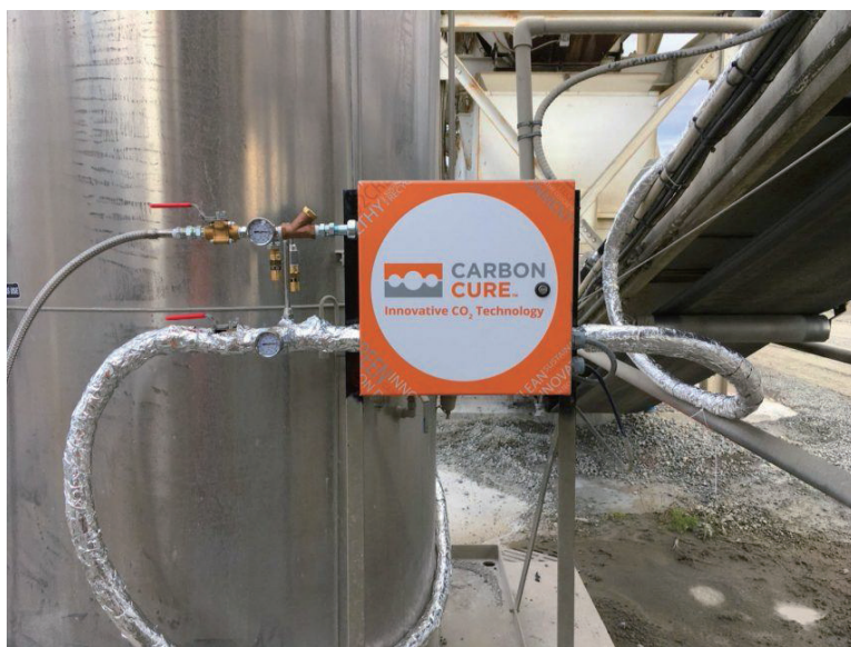
图 4 装有 CarbonCure 阀门的二氧化碳气罐 | 图源 CarbonCure
