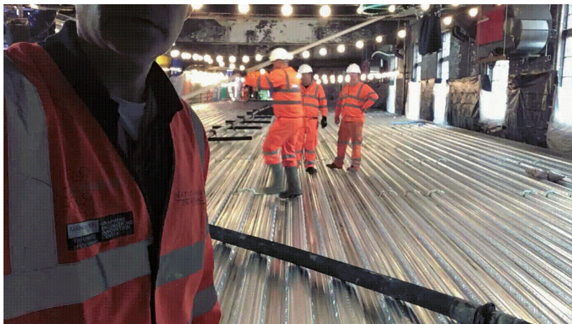
图6 用混凝土浇筑舞厅地板
