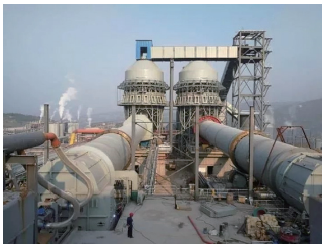
东方希望晋中铝业2×1000t/d活性石灰工程现场
