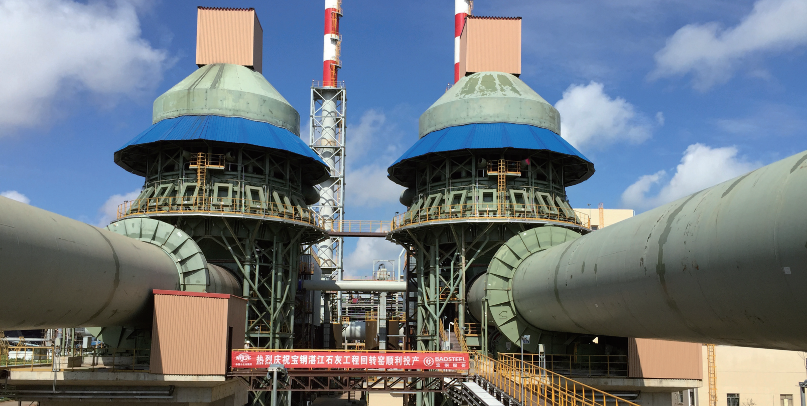
鹏飞集团承建的上海宝钢湛江 2×1000t/d 石灰生产线
